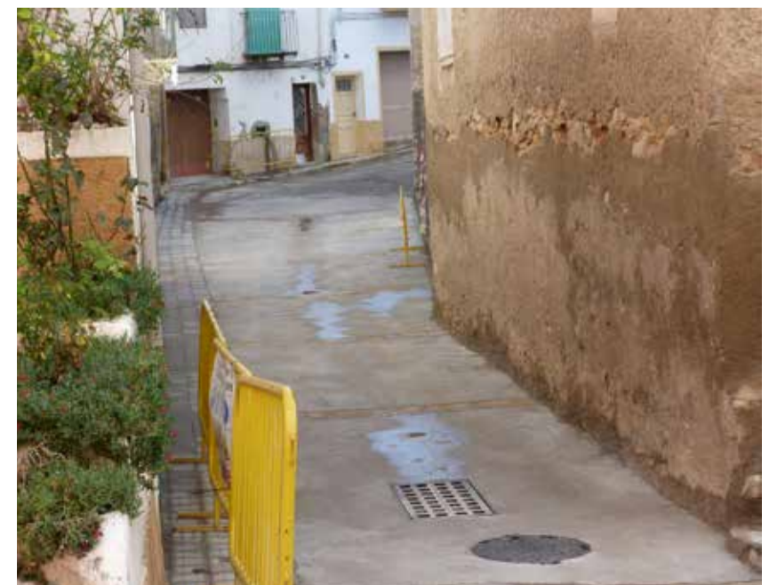
LA BRIGADA MUNICIPAL TAMBÉ HA SUBSTITUÏT LA XARXA DE CLAVEGUERAM, QUE ERA DELS ANYS 60 I ESTAVA MOLT DETERIORADA.
