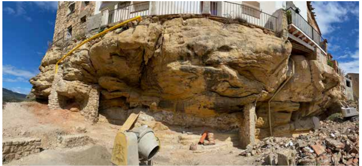
PEDRA SOBRE LA QUAL S'ASSENTA EL NUCLI ANTIC, AL DESCOBERT AMB ELS TREBALLS PREVIS.
